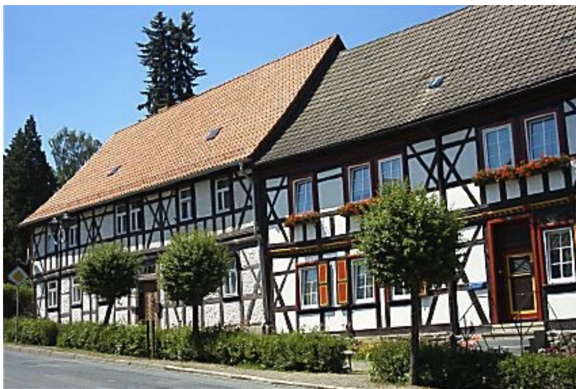
Fachwerkhäuser an der Marktstraße
