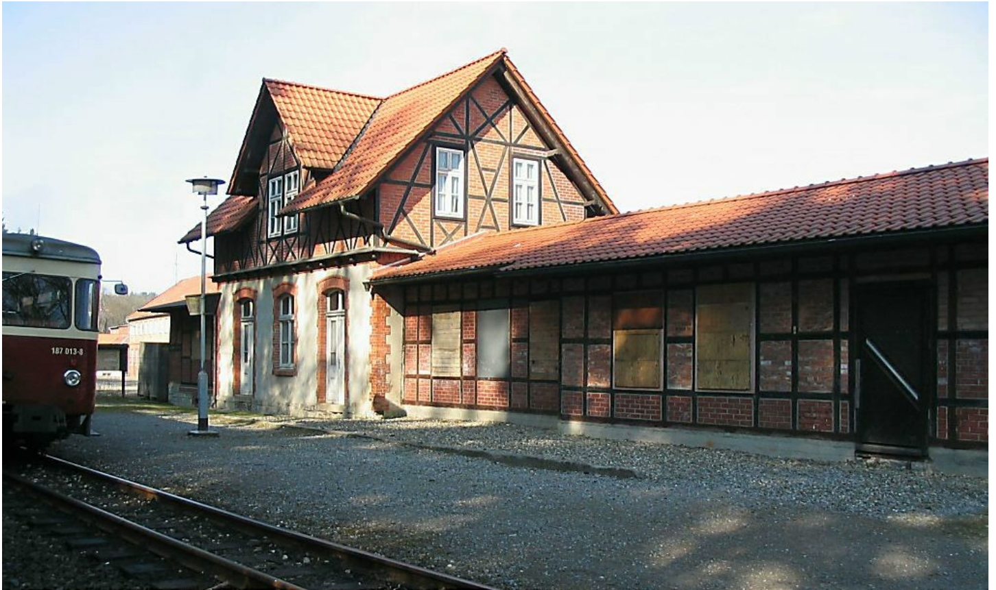
Bahnhofsgebäude von Güntersberge.
